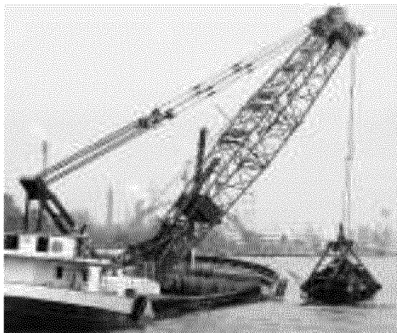
A sinistra l'escavazione dei canali con l'asporto dei fanghi
