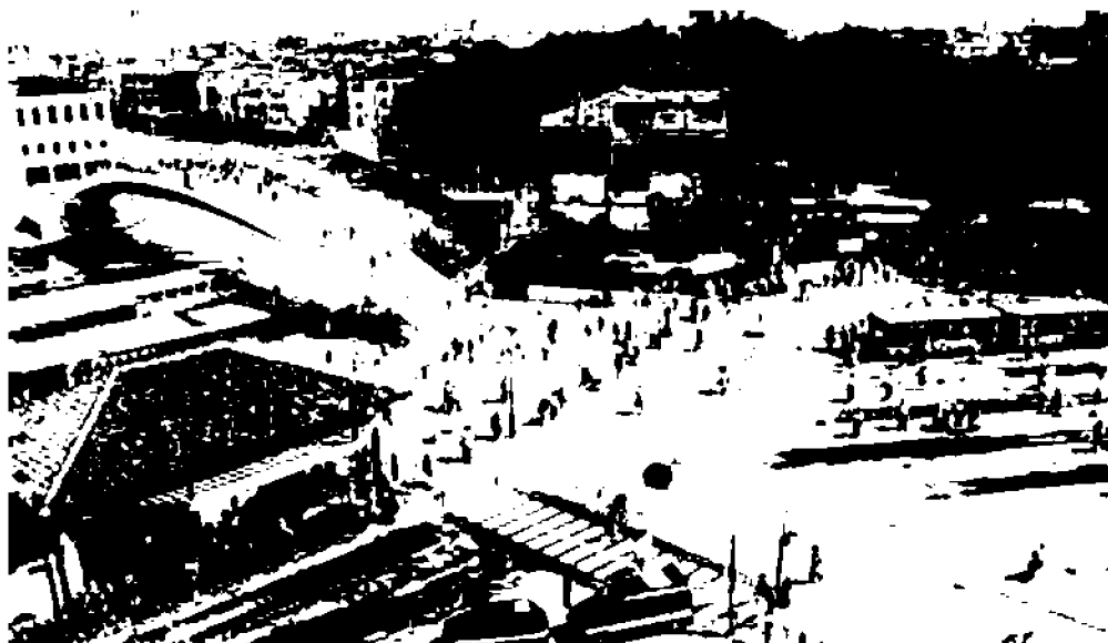
Dall'alto Piazzale Roma con l'albergo Santa Chiara e il ponte della Costituzione
